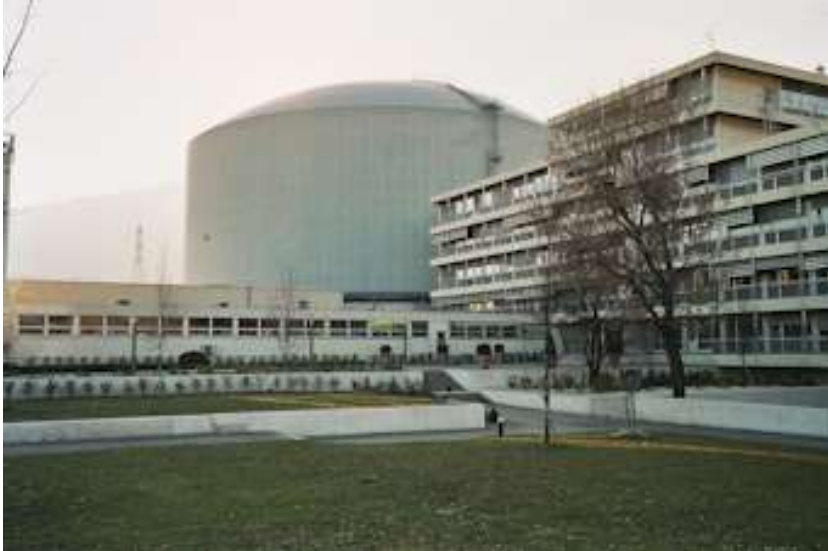
Foto van het reactorgebouw
