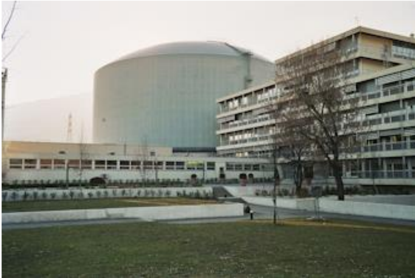
Foto van het reactorgebouw
