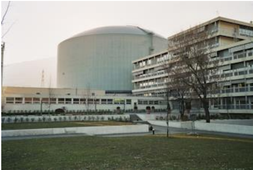
Foto van het reactorgebouw
